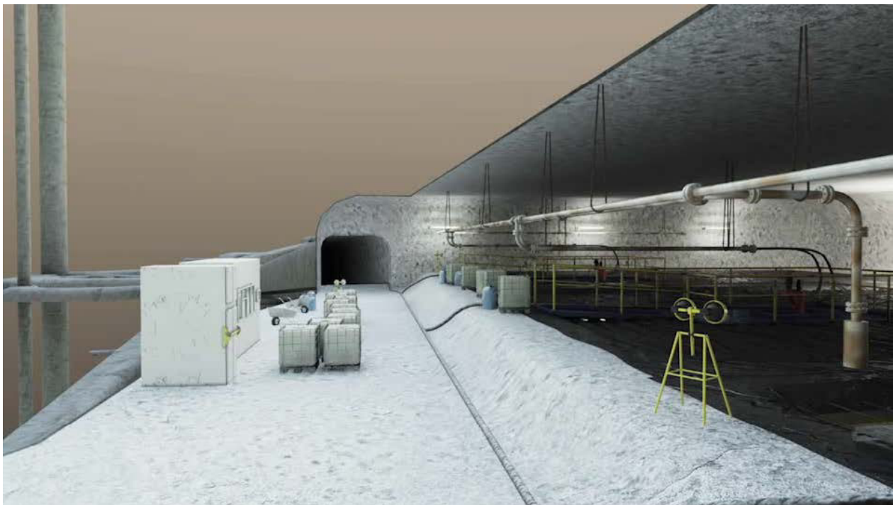
Abbildung 6: Zwischenspeicherbecken 490-m-Sohle (BfS, 2013b).
